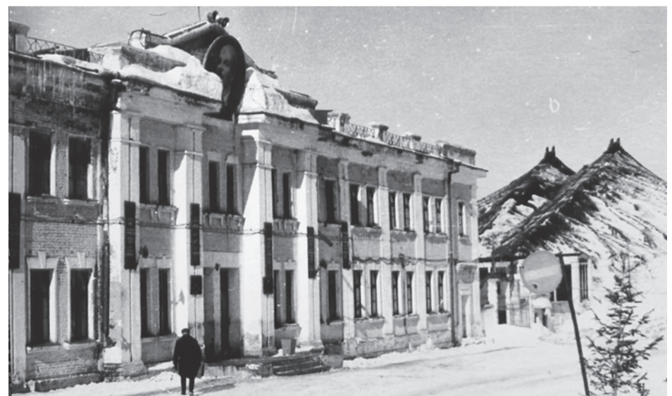
Шахта «Березовская». Начало
